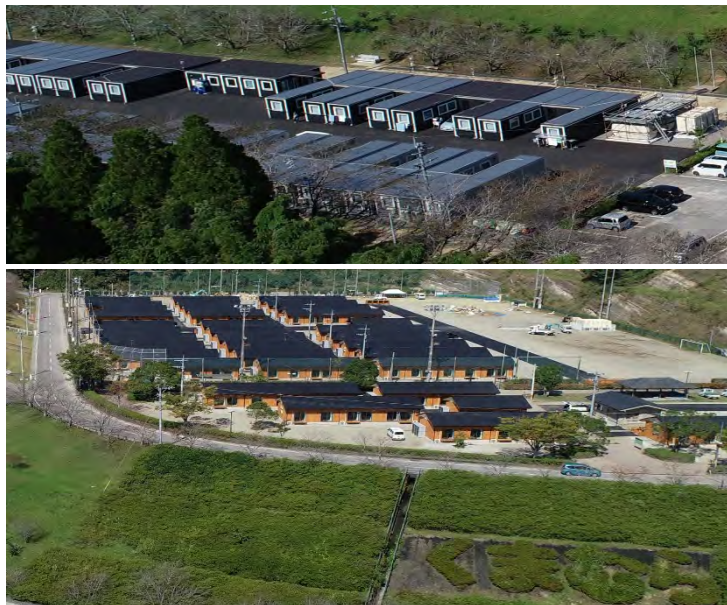
令和2年7月豪雨において住宅を被災した方々に応急仮設住宅を提供 上はムービングハウス(33戸)、下は木造仮設住宅(113戸) （写真提供：熊本県）
