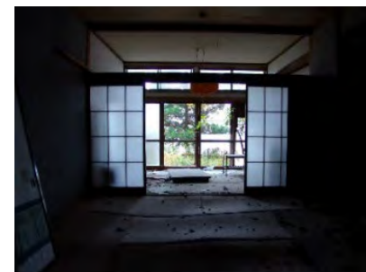
老朽化したホテル・旅館の改修
