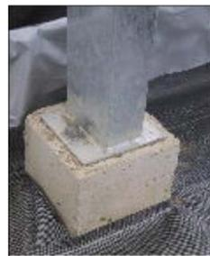
ソイルセメントによる基礎部の補強
