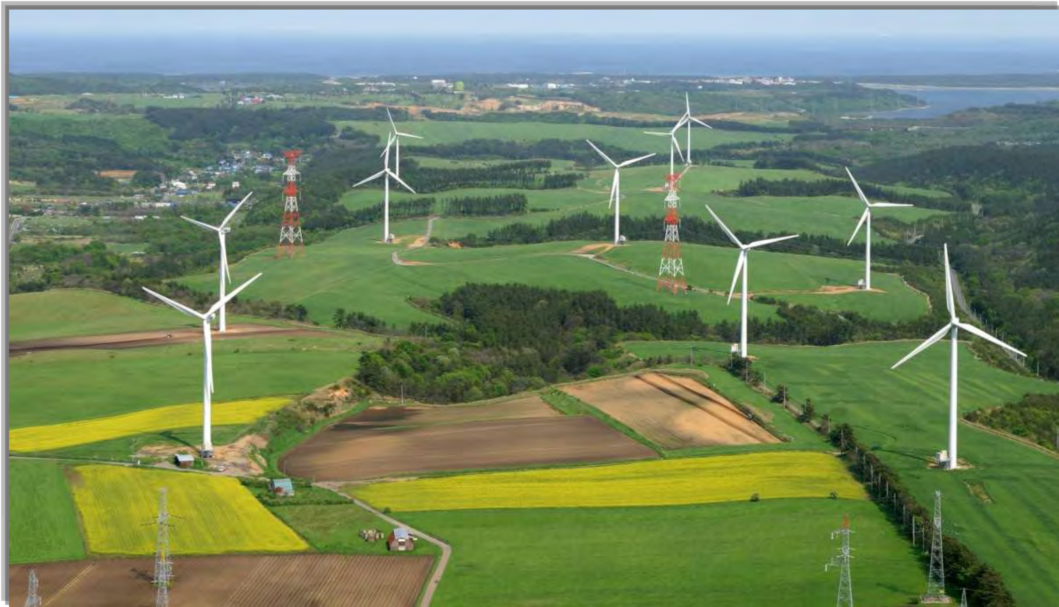
銚子風力発電所(千葉県銚子市、9基 13,500kW)
