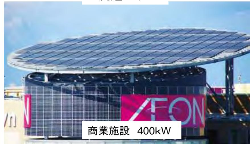
システム規模 300~400kW以上で、生産施設面積が3,000㎡以上となる。こうした規模のパネルを屋上に設置可能な建築物は工場立地法の対象となりうる。
