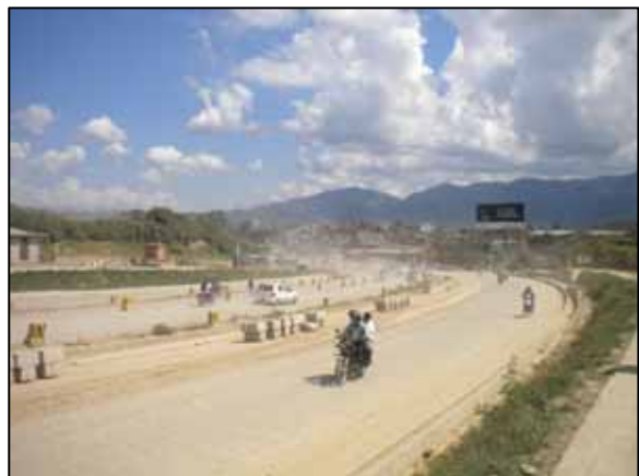
カトマンズ - バクタプール間の道路改修の様子
