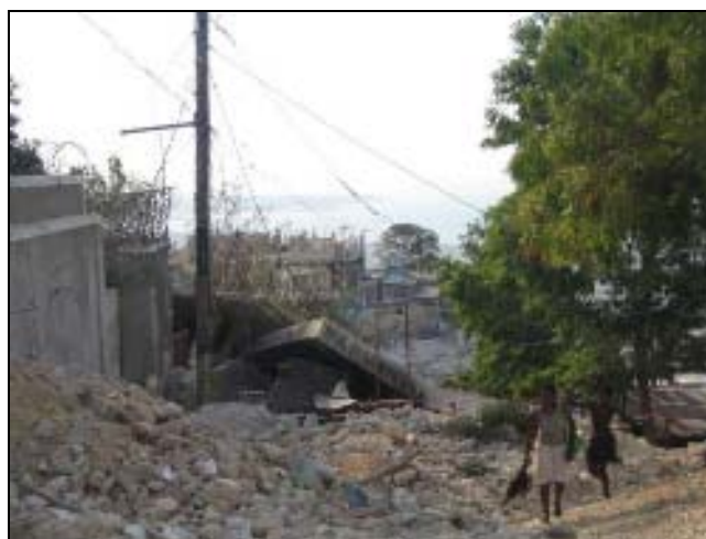
(倒壊したままの建造物)
