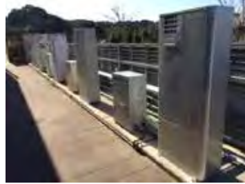
エネファーム (九大伊都に7台設置) 【家庭で発電効率50% 総合効率約90%超】
