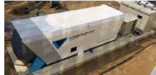
業務産業用・発電用燃料電池 (三菱日立パワーシステムズ製、九大伊都設置) 【将来、天然ガスで発電効率約70%へ】
