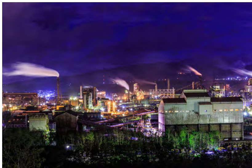
工場での設備モニタリング
