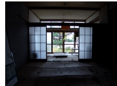
老朽化したホテル・旅館の改修
