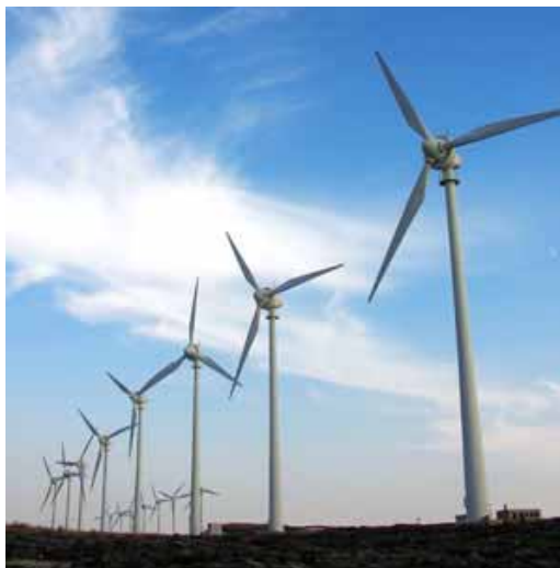
風力発電プラント
