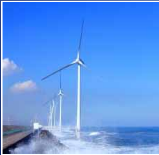
鹿島港の洋上風力発電 (ウィンドパワーかみす)
