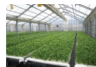
農業生産施設 （水耕栽培ハウス）
