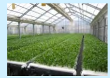
農業生産施設(水耕栽培ハウス)
