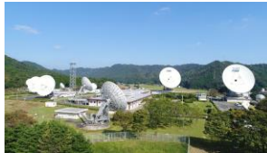
衛星通信システム の地上設備
