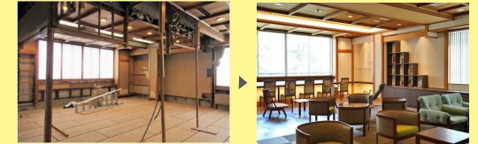
ほほえみの宿滝の湯 特別フロア専用ラウンジ改修
