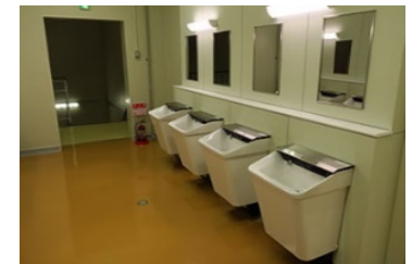
衛生管理の改善のための 手洗い設備の改修
