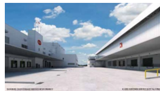
【海外の冷蔵・冷凍物流倉庫】
