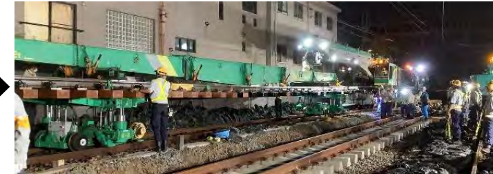
大型機械作業
