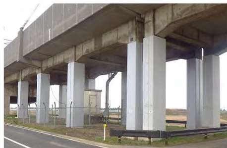
高架橋柱耐震補強
