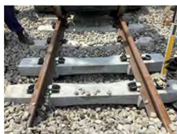
軌道構造強化 (弾性PC化)
