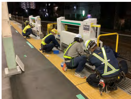
ホームドア工事
