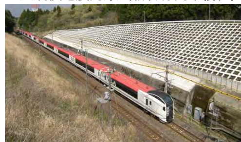
切取りの面工（吹付砕工）
