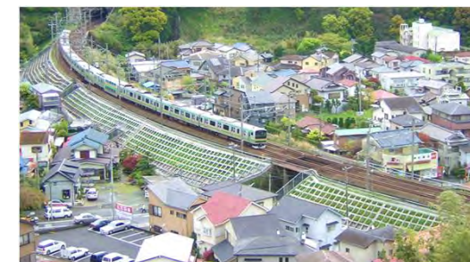
盛土のり面工（吹付砕工）
