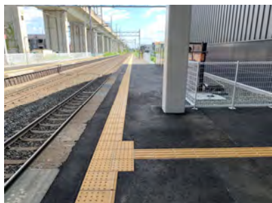
視覚障害者誘導用ブロック
