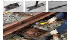
分岐器ベアリング 交換器具の開発
