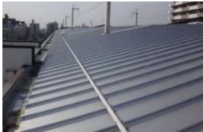
屋根飛散・落下防止対策（金属屋根）
