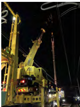
新幹線電化柱 建替用保守用車
