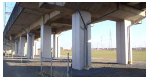
大規模地震対策（新幹線高架橋柱）
