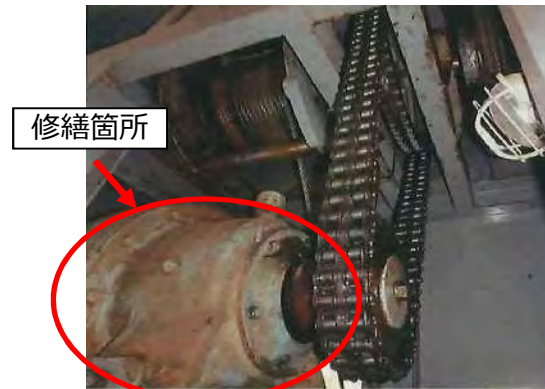
取水口除塵機部分修繕（駆動装置）
