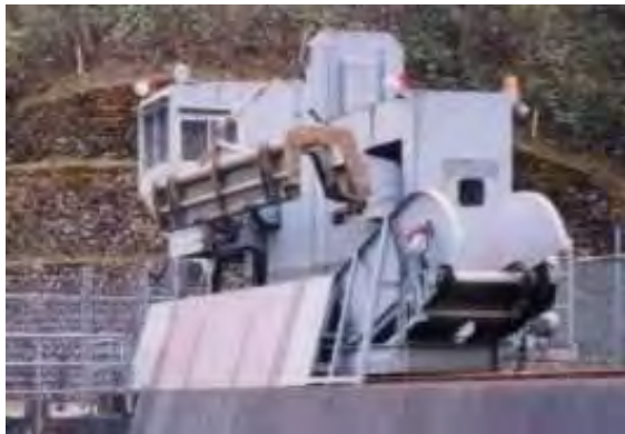
取水口除塵機 全景
