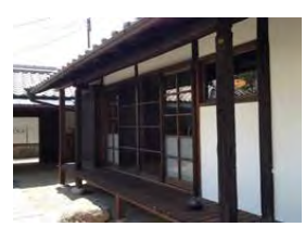
古民家を宿泊施設に改装して運営（明日香村おもてなしファンド）
