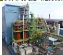
12m 3 小規模試験高炉(水素還元)
