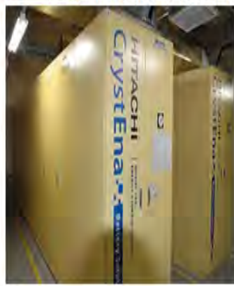
■ゲートスクエアのリチウムイオン電池
