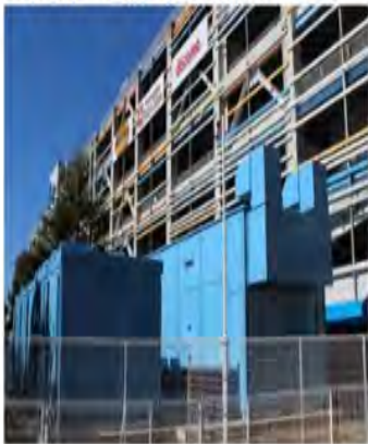
■ららぽーと柏の葉のNAS電池
