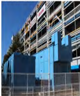
■ららぽーと柏の葉のNAS電池
