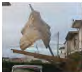
<飛来物による電柱倒壊（東金市）>
