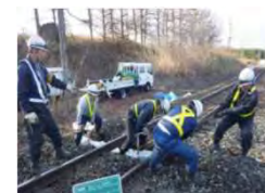
鉄道施設の設備投資や修繕
