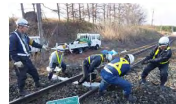
鉄道施設の設備投資や修繕
