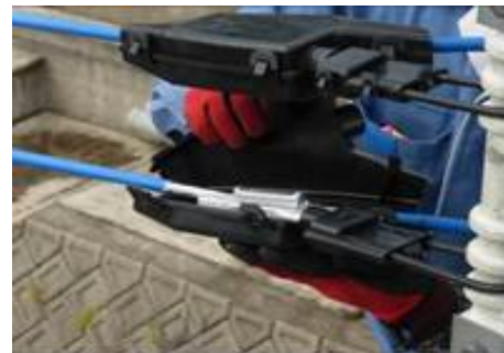
[アルミ電線の支持工法検証]
