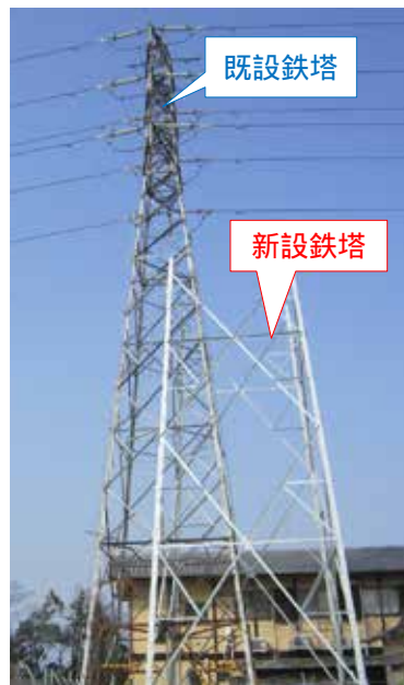
新設鉄塔組立状況
