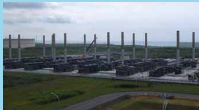
苫小牧発電所2号機～83号機 出力：7.4万kW
