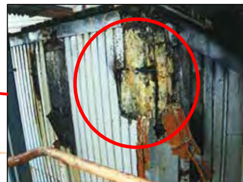
ダクトの損傷事例
