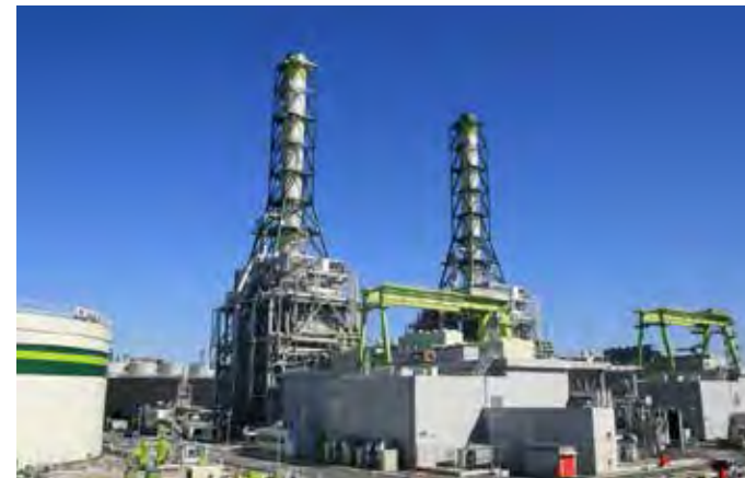
川崎天然ガス発電所
