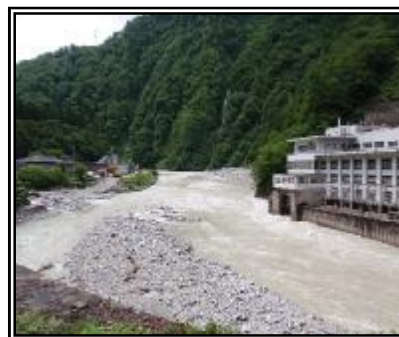
出水による放水口土砂堆積 (富山県)
