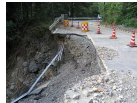
降雨による道路陥没 (京都府)
