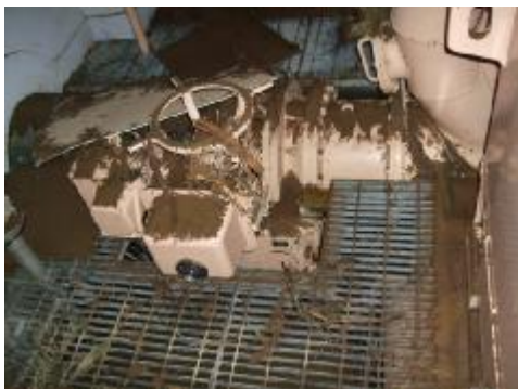
出水による発電所内浸水 (和歌山県)
