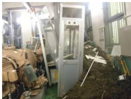
土砂崩れによる建屋損壊 (滋賀県)
