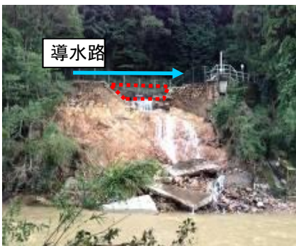
土砂崩れによる導水路損壊 (滋賀県)
