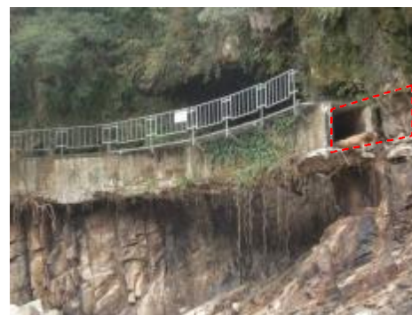
降雨による導水路崩落 (和歌山県)
