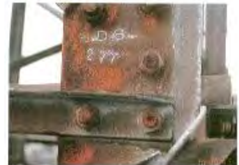
劣化度Ⅳの状況 (メッキ層消失、鉄腐食の進行)
