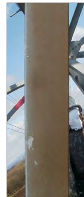
劣化度Ⅲの状況 (メッキ層が薄くなる)
