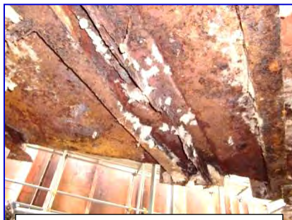
煙道(底板)外部腐食状況
