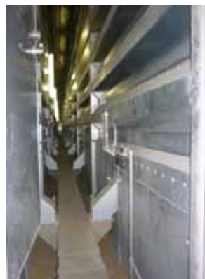
品種毎にもみを保管 (両側が保管庫)
