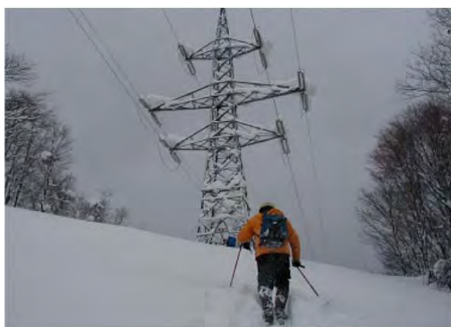
〔送電設備の巡視点検〕
