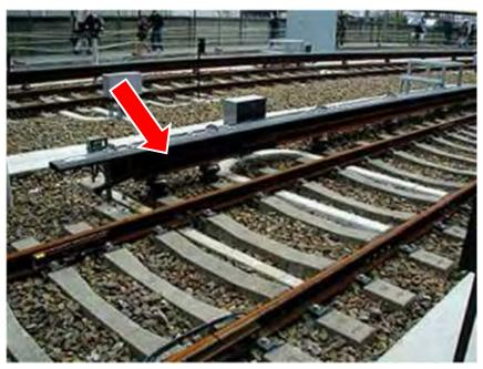
地下鉄の第3レールから 電流が漏れてベアリングが 腐食した
