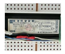
●昭和52年(1977年)3月以前に建築された建物については、PCB使用安定器が設置された可能性があります。PCB使用安定器が使用・保管されている場所の例を以下に示しますので参考にしてください。
