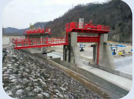
(頭首工の土砂吐ゲートの開閉装置更新、扉体塗装)
