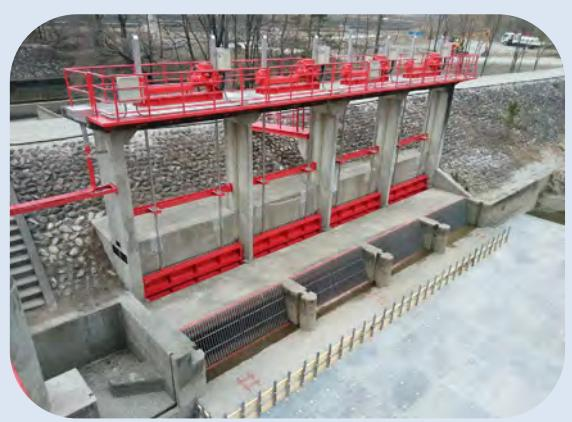
(頭首工の取水ゲートの開閉装置更新、扉体塗装)
