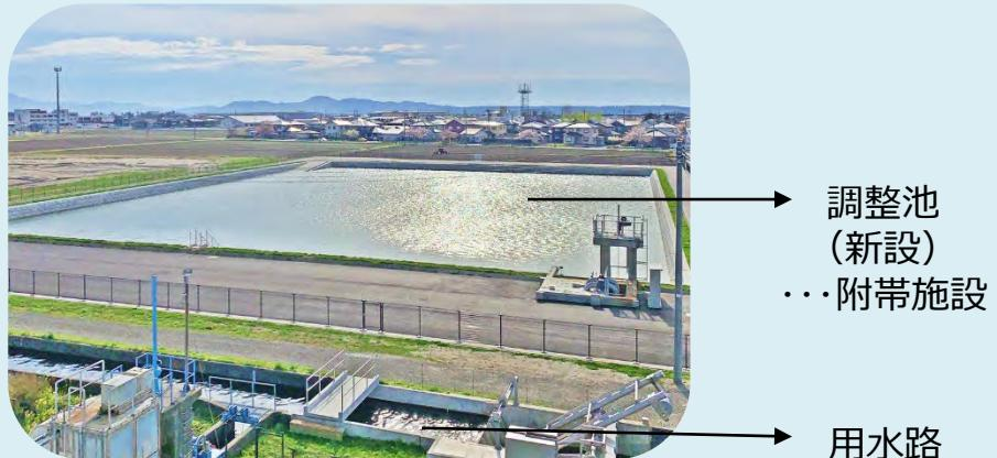
用水需要の多様化に対応するため、水量の変動を調節する調整池を
