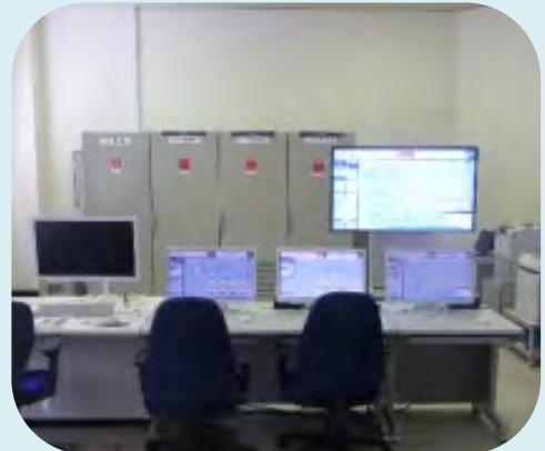
(ダムの操作卓をグラフィックパネルから大型液晶パネルへ更新し、水管理施設システムを高度化)
