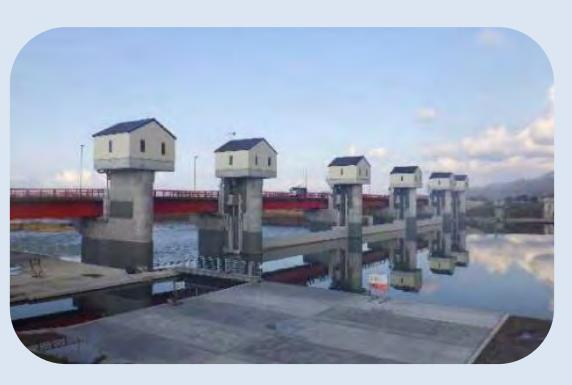
(頭首工の上屋の更新、堰柱の表面補修)
