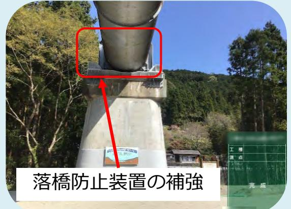
(地震による落橋は発生しないよう、落橋防止装置を補強)
