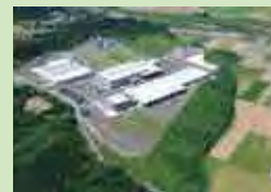
周囲を自然林に囲まれ、環境保全と調和した立地が実現している工場
