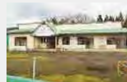
閉所後、放置されていた旧保育所
