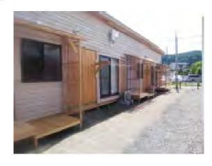
〇プレハブメーカーによる応急仮設建築物 (応急仮設住宅)
