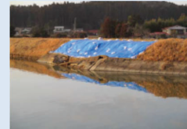
ため池堤体法面をブルーシートで養生
