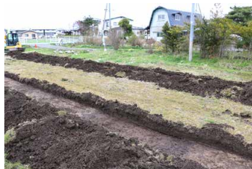
農地での試掘調査の様子
