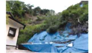
豪雨の度に土砂崩れが多発
