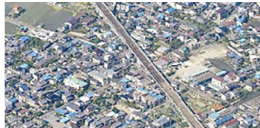
屋根瓦が落ちる被害が多発し、ブルーシートでの応急処置を実施
