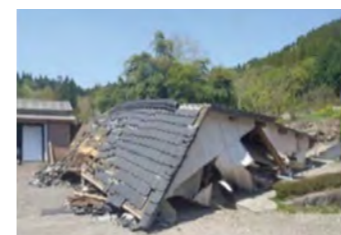
被害状況①(由布市湯布院町)
