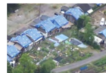
被害状況②(由布市庄内町)
