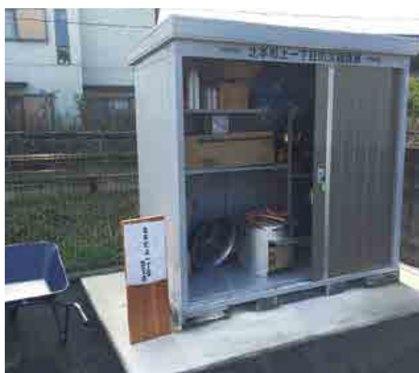
建築確認が不要な「小規模な倉庫」として設置された防災備蓄倉庫
