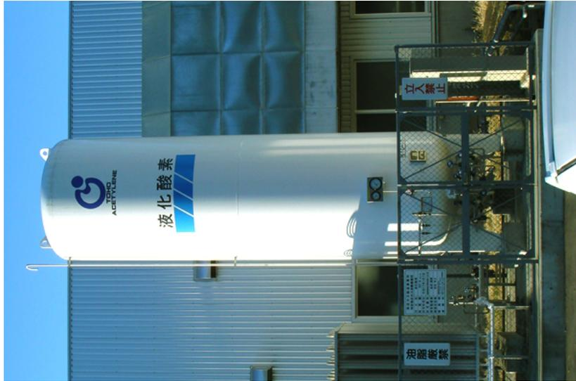
加圧機能 (高圧ガスを製造する機能) を有する液化ガスの貯蔵タンク
