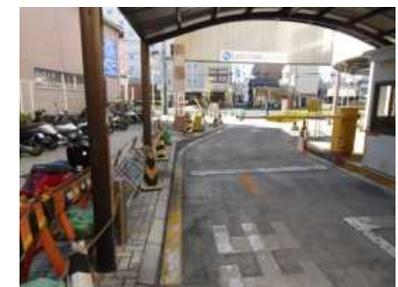
出庫ゲートバーを短くカットし、自動二輪車が通ることができるよう改修(右)
