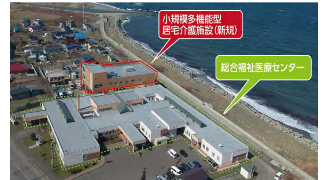
総合福祉医療センター及び建設予定地
