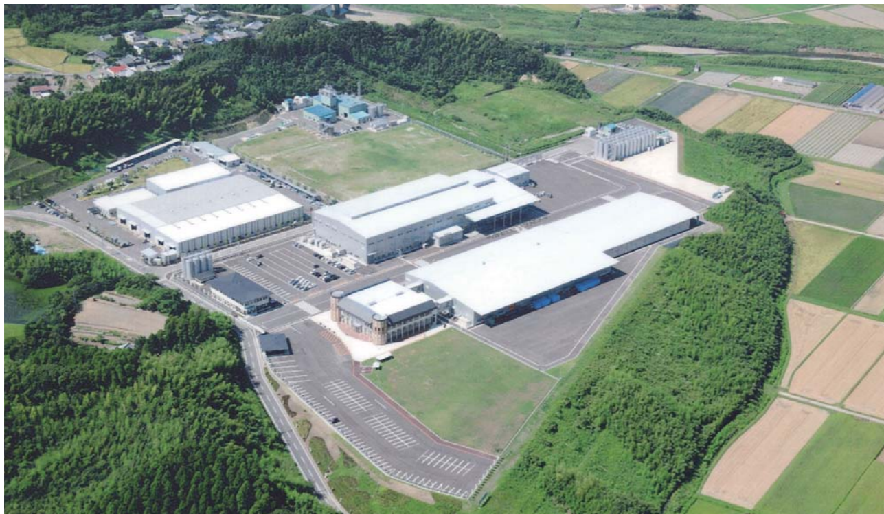
敷地の周囲を自然林に囲まれ、環境保全と調和した立地が実現している西都市にある工場 敷地内の芝生広場は地域住民や来場者に開放されている
